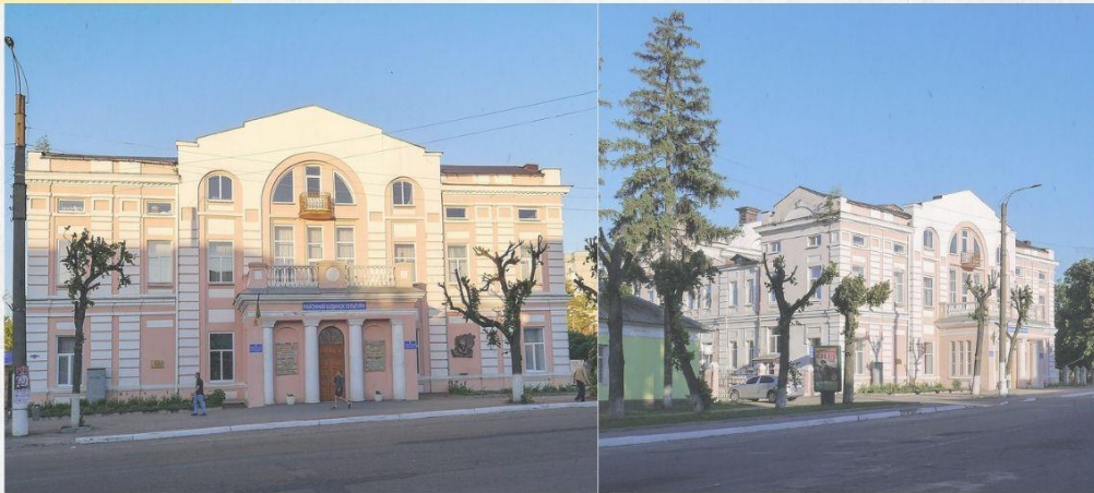
Фотофіксація до руйнування (фото до 2022 р.)
