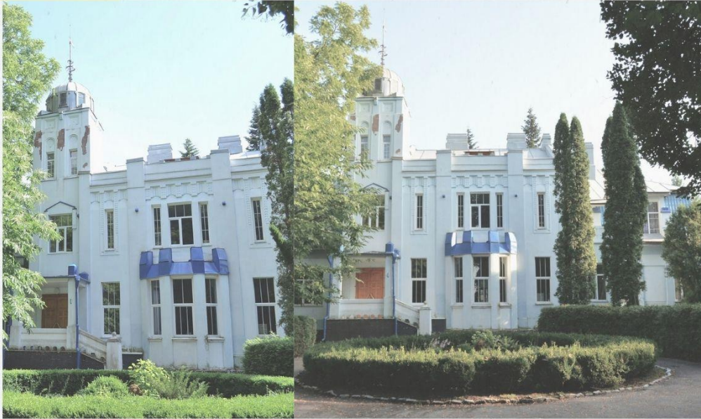
Фотофіксація до руйнування (фото до 2022 р.)
