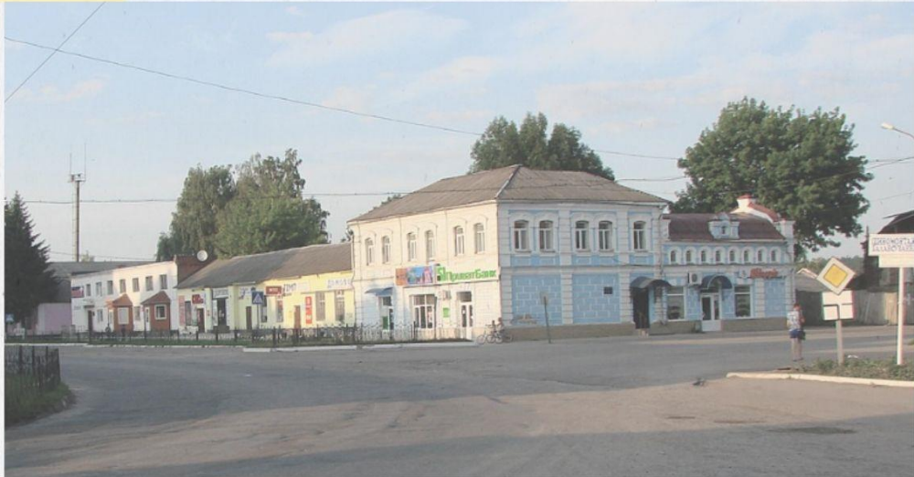
Фотофіксація до руйнування (фото до 2022 р.)
