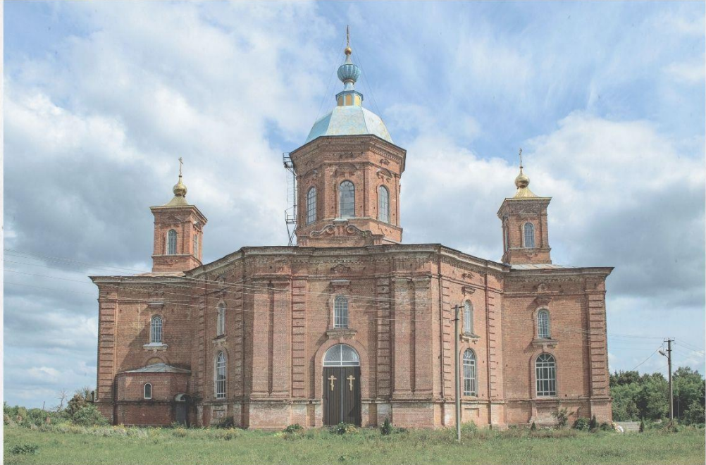
Фотофіксація до руйнування (фото до 2022 р.)
