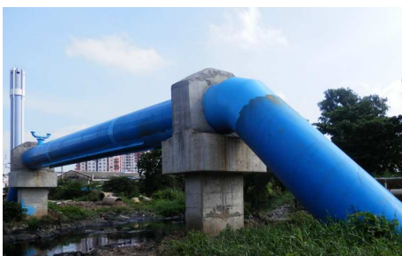
Рис. 12 Перехід над перешкодою магістрального трубопроводу
