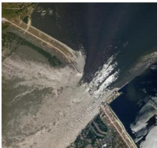
Зруйнована Каховська ГАЕС
