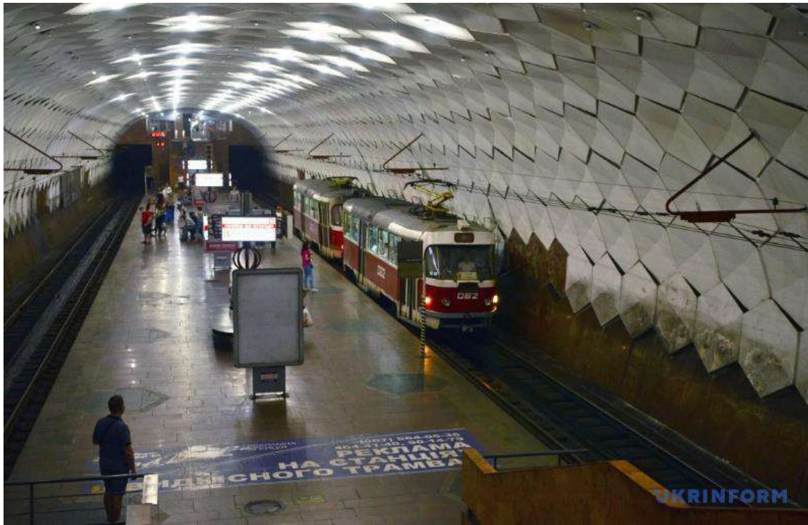
Рис 3.3. Підземна станція криворізького швидкісного трамваю
