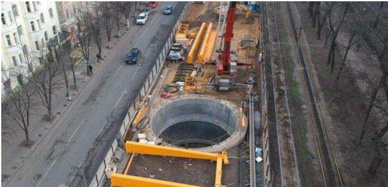
Рис. 1.7. Будівництво продовження дніпровського метрополітену
