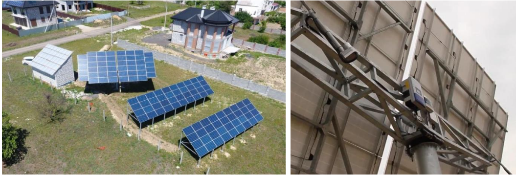
Рис. 1. Загальний вид змонтованих сонячних трекерів.
