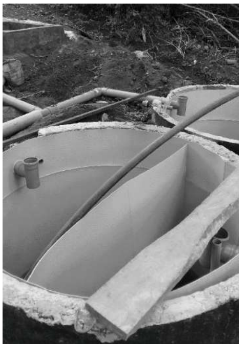
Рис. 2. Монтаж полімерних конструкцій в існуючих бетонних стінках очисних споруд
