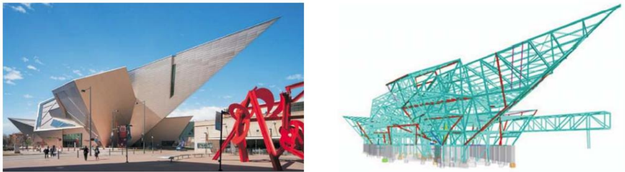
Рис.2.5. Видгляд фасаду та BIM модель каркасу Музею мистецтв (Денвер, США) [96, с.92]
