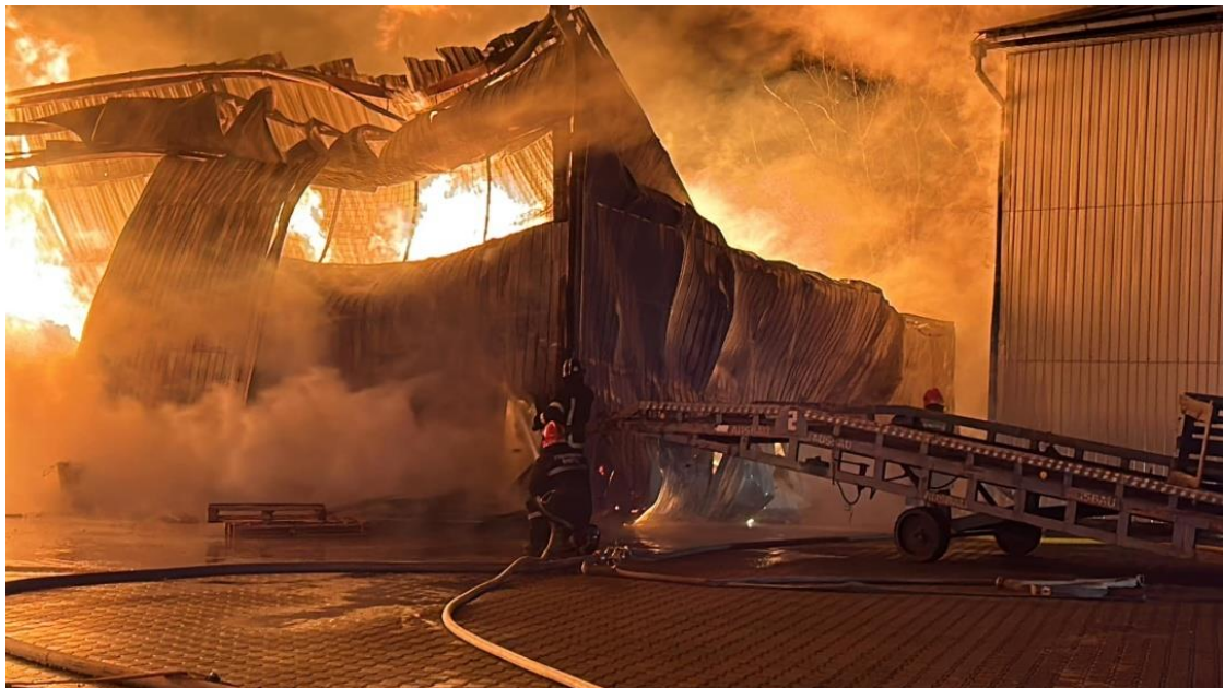
Рис. 1.3. Обвалення сталевих конструкцій складу внаслідок пожежі, Вінниця
